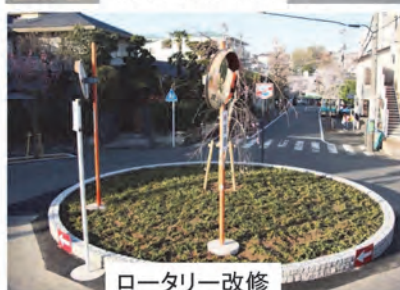
ロータリー改修
