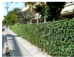
■ブロック塀の緑化
