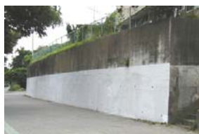
■擁壁の緑化（整備前⇒整備後）
